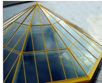
Рис. 1. Зенитный фонарь зимнего сада снаружи
