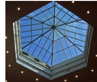
Рис. 2. Зенитный фонарь зимнего сада изнутри
