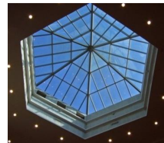
Рис. 2. Зенитный фонарь зимнего сада изнутри
